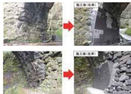
写真-6 下部補修の施工直後 (H28撮影)
