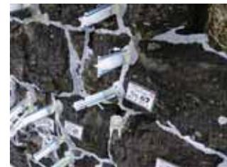
写真-5 ひび割れ充填
