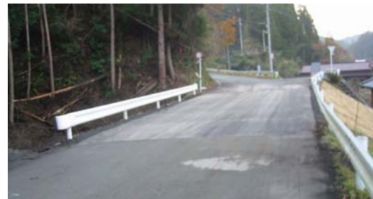
写真-2 復旧後の状況
