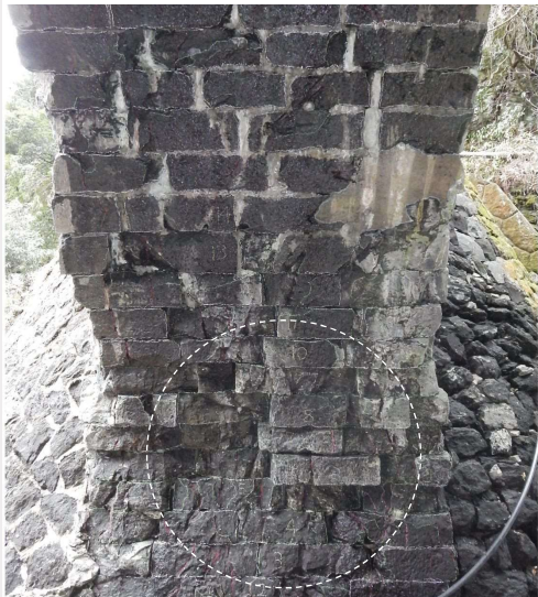
右岸側アーチ内面部
