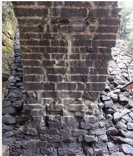
左岸側アーチ内面部
