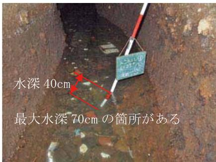
写真-6 底部の洗掘状況
