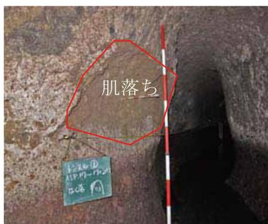
写真-1 側壁の剥落跡
