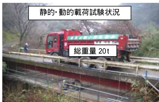
写真-1 載荷試験
